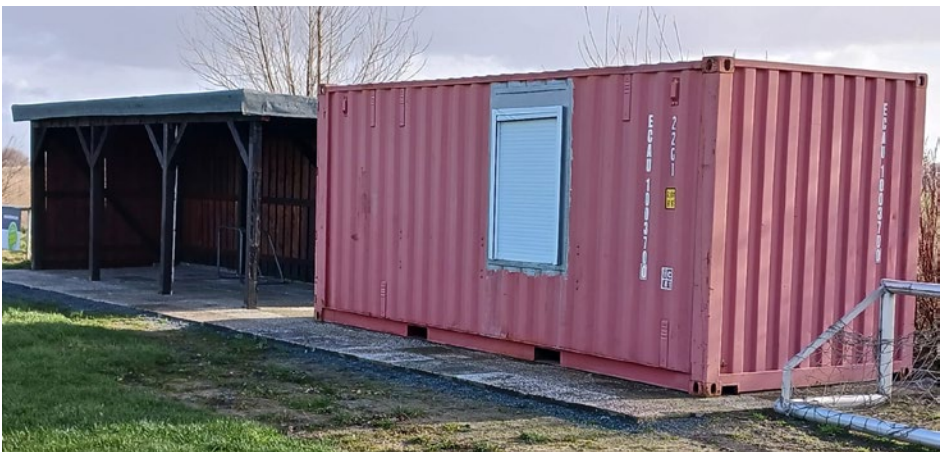
Neu hergerichteter Unterstand mit Versorgungscontainer in unmittelbarer Nachbarschaft auf dem Wremer Sportplatz.
